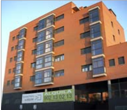
Las viviendas del Ensanche de Vallecas que ya gestiona la SPA. / J. S. C.
